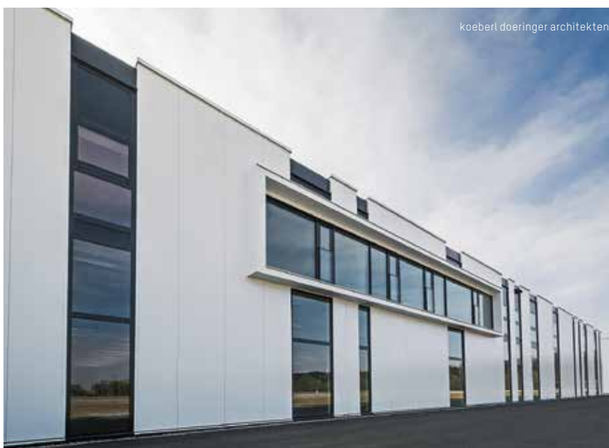
Mikroliniertes ROMA Paneel mit unsichtbarer Befestigung für ästhetisch hochwertige Fassaden.
