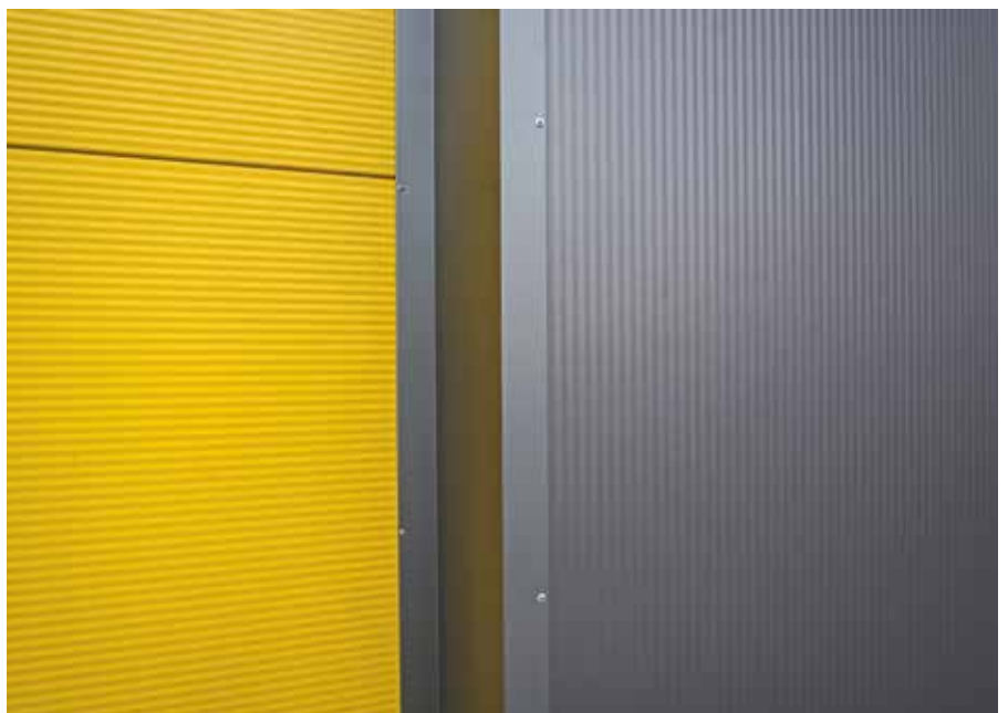
Horizontale und vertikale Verlegung
