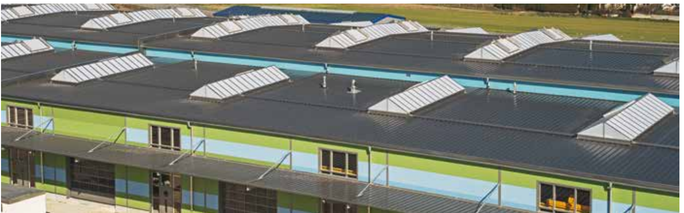
Produktionshalle mit 24 m langen Dachpaneelen
